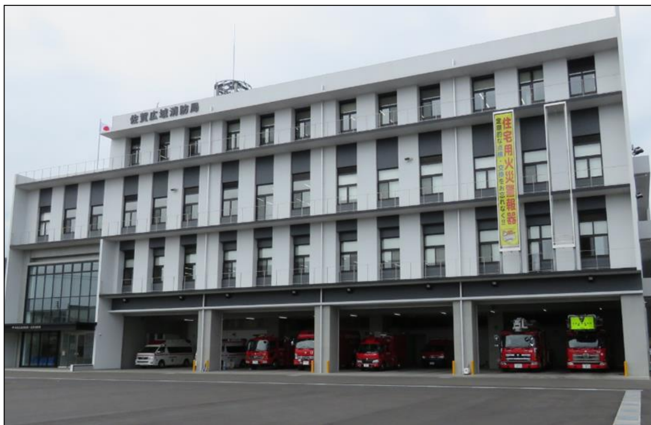
佐賀広域消防局庁舎
