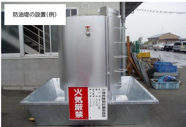
鉄板垂鉛メッキ加工の防油堤（タンク一体型）
