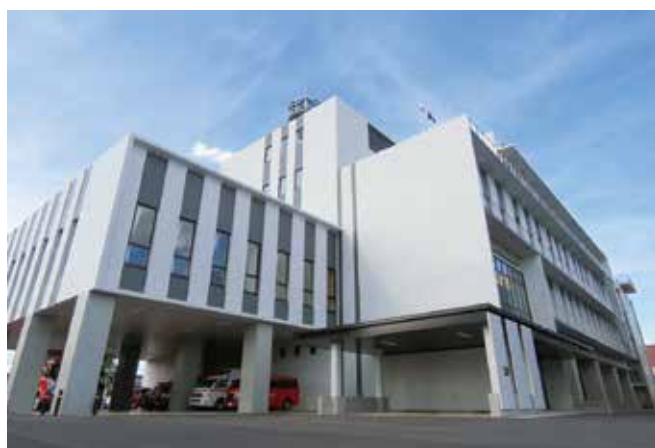
佐賀広域消防局新庁舎
