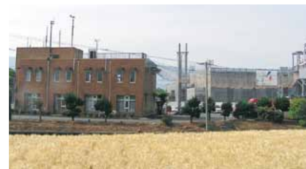
小城地区消防署の改築
