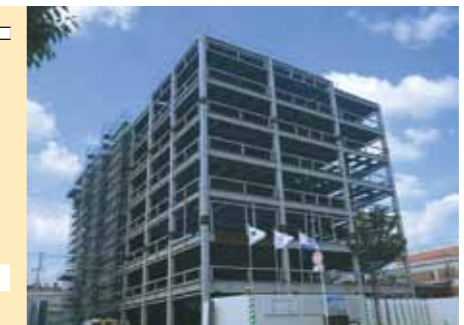
建築中の佐賀商工ビル(佐賀市白山)
