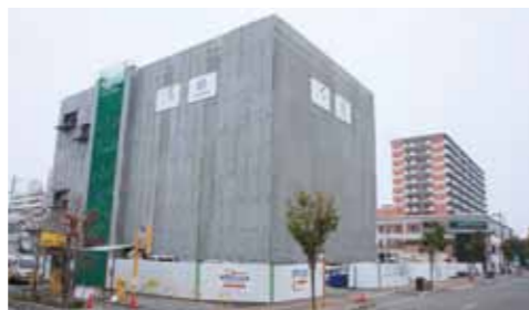
建築中の佐賀商工ビル(佐賀市白山)
