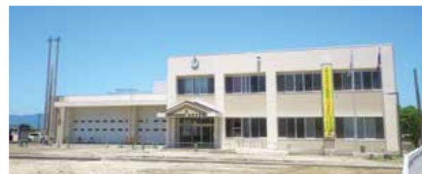
完成した南部消防署
