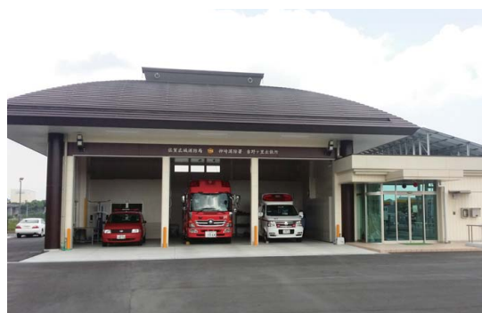
平成27年3月に新築を終えた 佐賀中部広域消防局吉野ヶ里出張所
