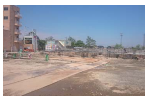
南部消防署改築中
